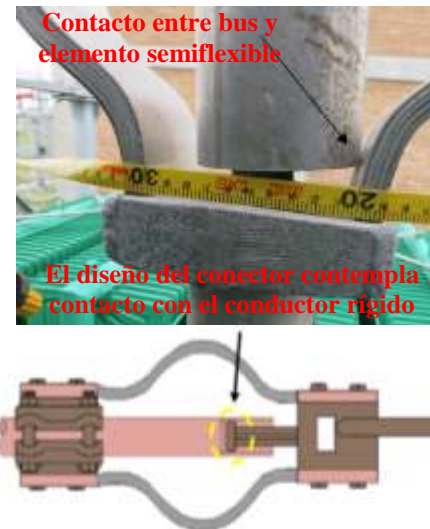
Fig. 5. Detalles de acoplamiento entre el conector FZ y el bus [Ref.3]
