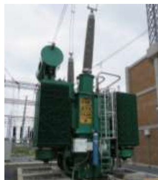
Fig. 1. Transformador monofásico
