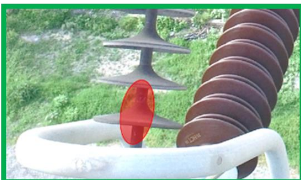
Fig. 2. Inspección y determinación Del Estado Físico de Aislamiento Sintético
