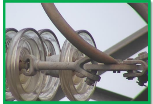
Fig. 3. Inspección del estado físico de aislamiento en vidrio o porcelana y herrajes
