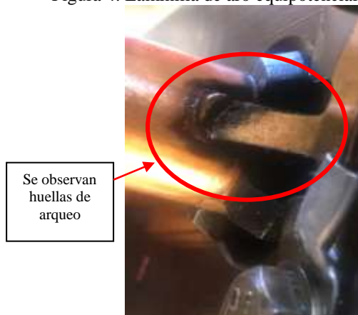
Figura 4. Laminilla de aro equipotencial fase A.
