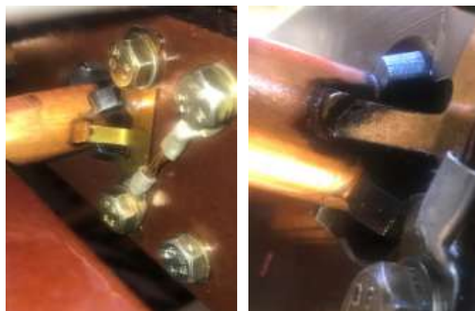
Figura 6, Laminilla de aro equipotencial fases B y C sin huellas de arco en buen estado.
