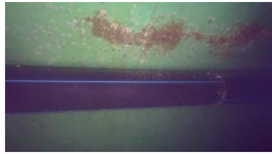
Fig. 8. Tubería submarina luego de los trabajos de limpieza y sustitución de tubería de cloración
