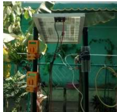
Fig. 7. Instalación del panel solar en espacio cerrado (4 paredes).
